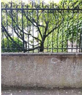
**Mur bahut** : muret surmonté d'une grille de clôture, ajourée ou non.
