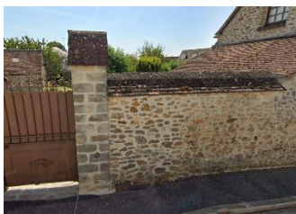
Mur en moellons ©Google Maps
