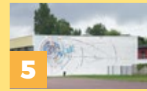
Complexe Langenargen Rue Moreau de Tours
