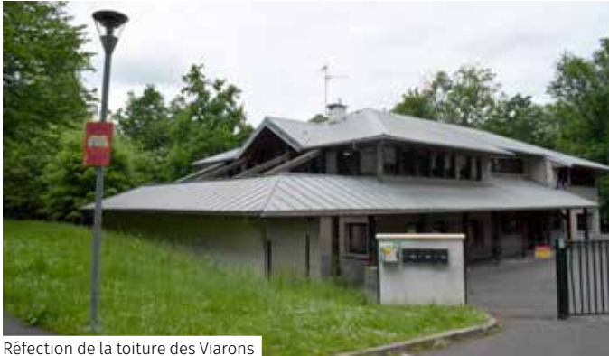
Réfection de la toiture des Viarons
