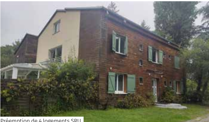
Préemption de 4 logements SRU
